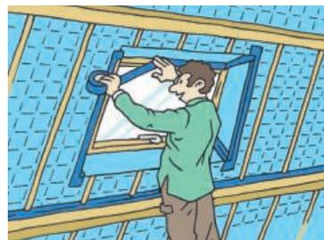
L'isolant doit lui aussi être placé de manière continue (sans interruption) pour éviter les ponts thermiques, sources de condensation et de moisissures à la surface des parois. ➔
